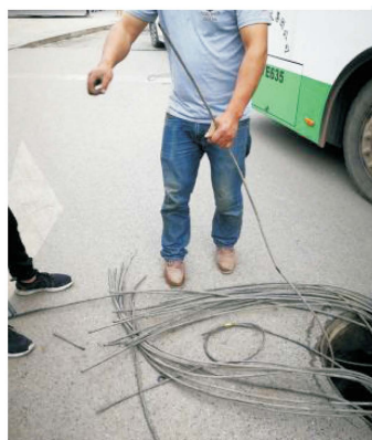
市政施工 暴力扯断
